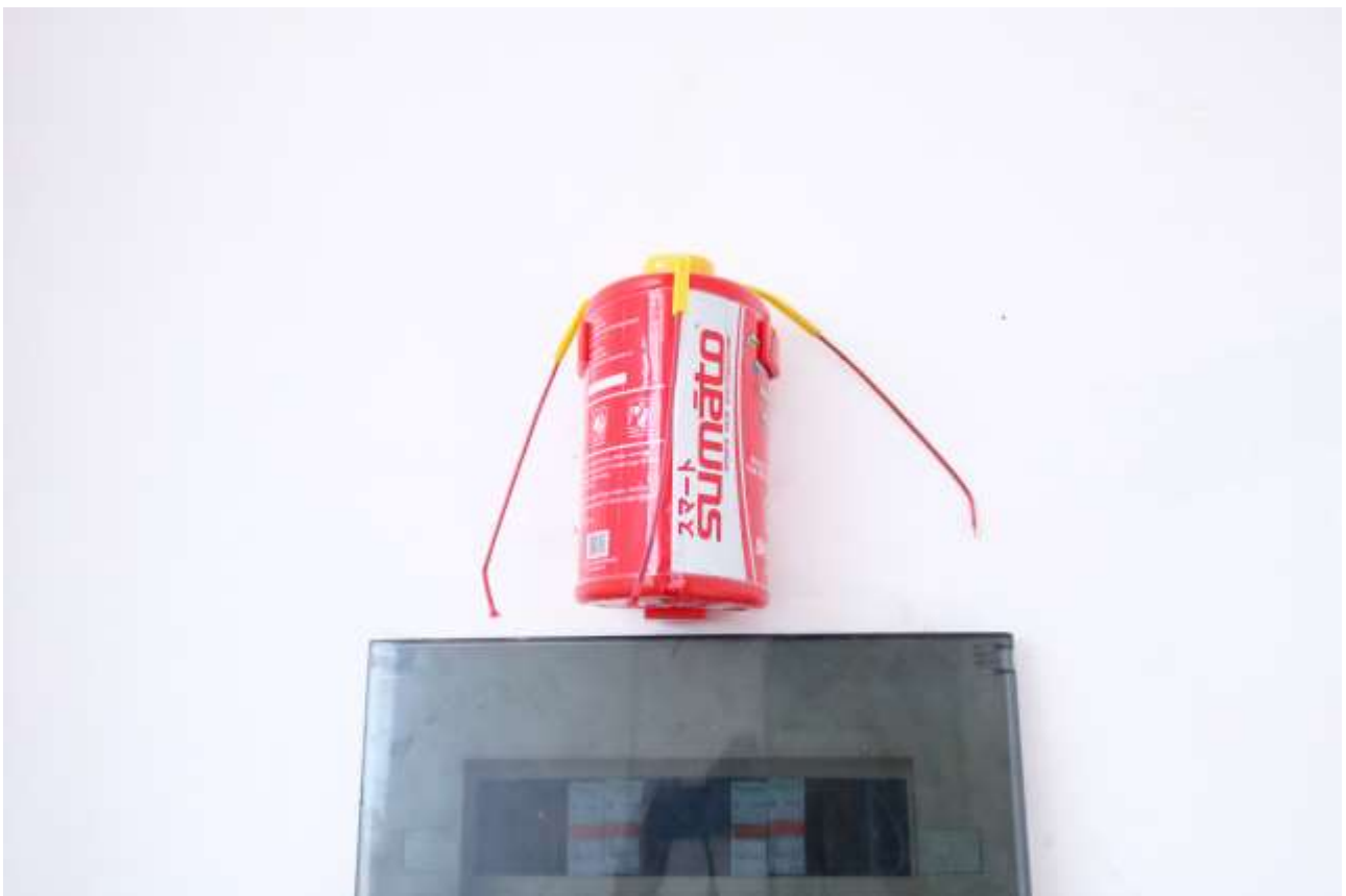
8) Tampilan produk Sumato SM-08 setelah terpasang dengan benar
