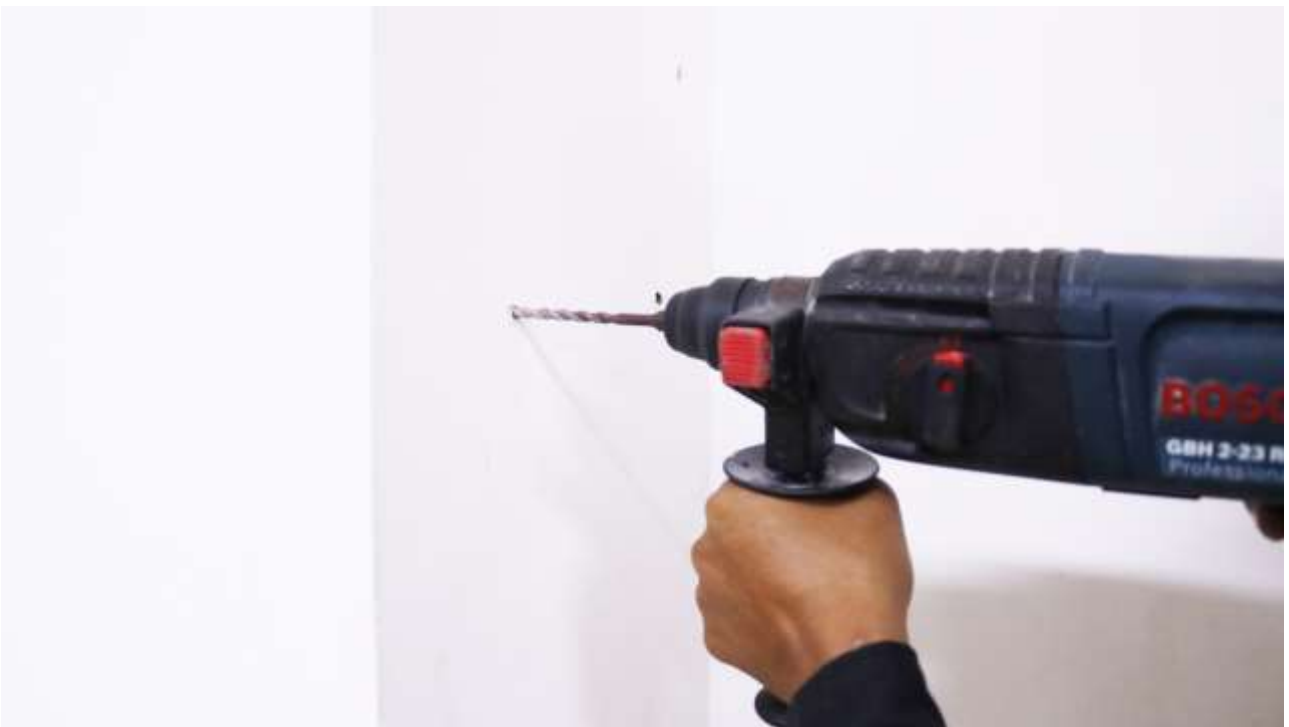
3) Lubangi lokasi pemasangan (menggunakan alat Bor)
