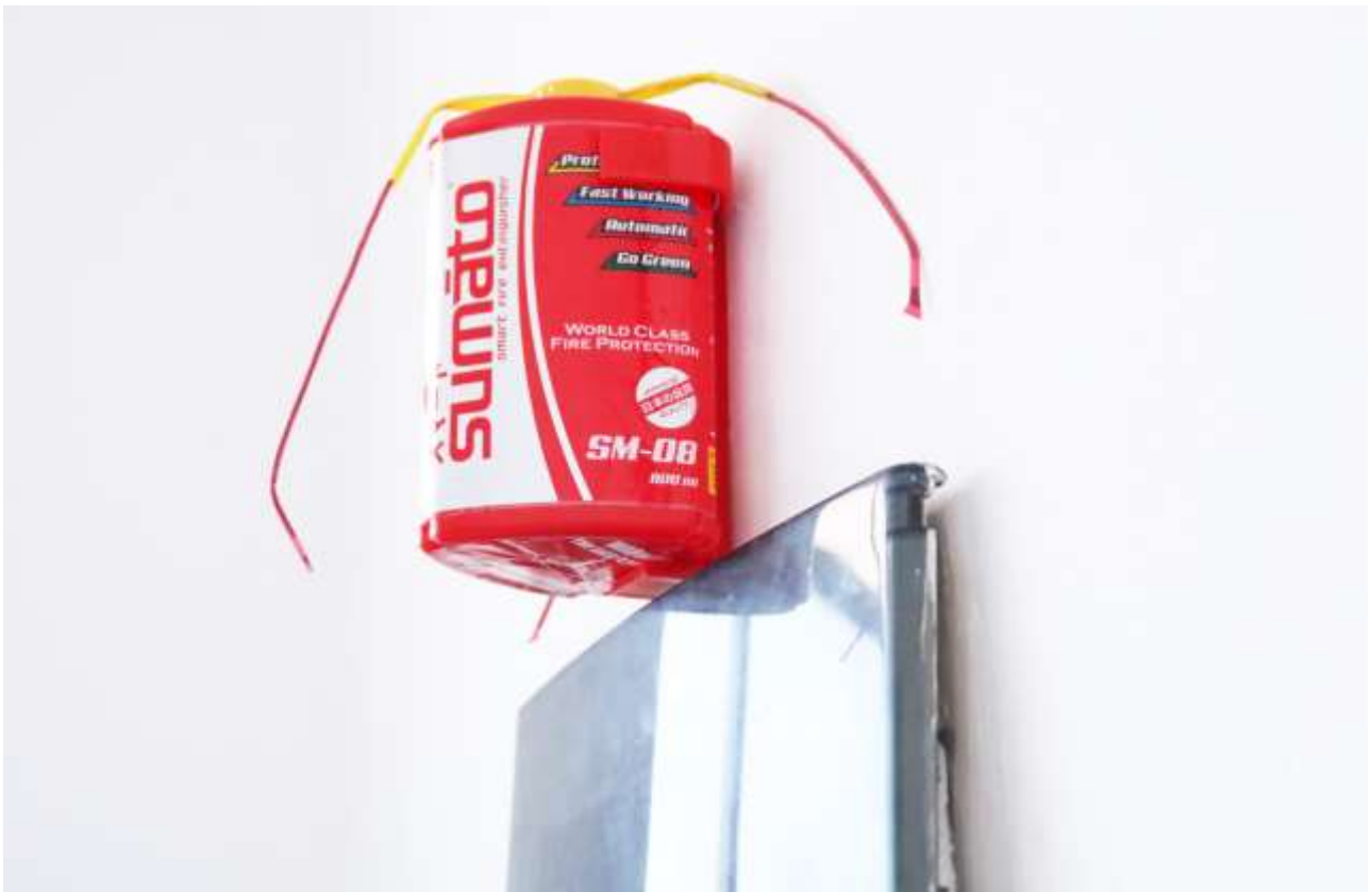
8) Tampilan produk Sumato SM-08 setelah terpasang dengan benar
